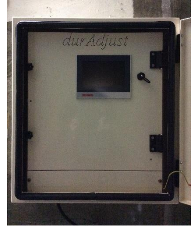
Contrôleur esclave – Unité centrale et contrôleur esclave sur sens Y – unité centrale
