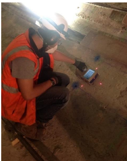
Anodes discrètes - intérieur des bracons
