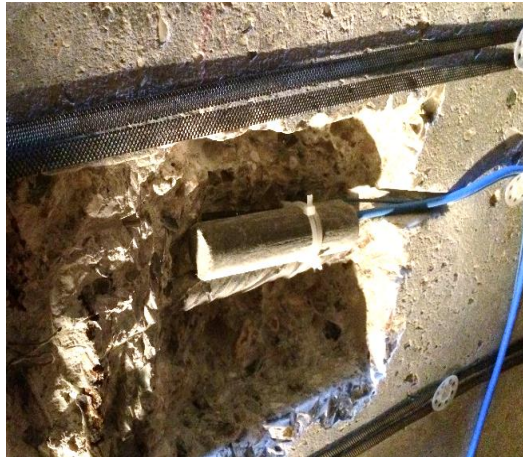
Forage des trous – vérification des trous – scellement des anodes
