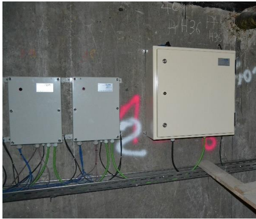
Contrôleur esclave – Unité centrale et contrôleur esclave sur sens Y – unité centrale
